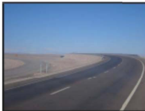
Km 67,3. Paso superior de FFCC Cochrane
