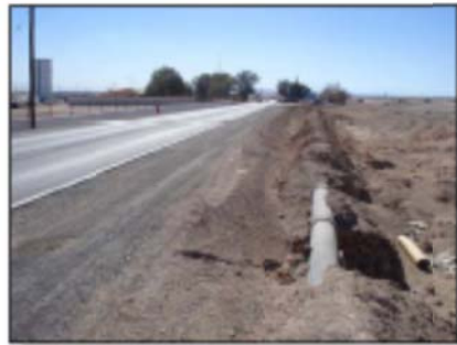
Km 107,4. Tuberías AP costado derecho
