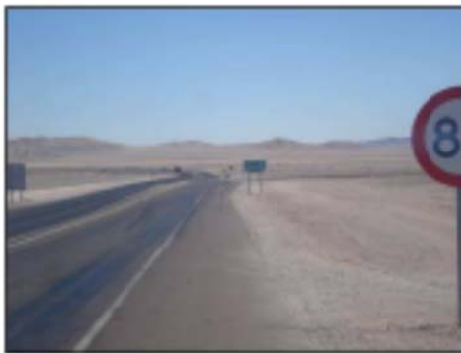
Km 52,3. Acceso a mina Spence
