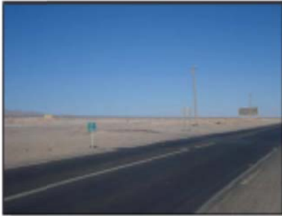
Km 107,3. Cruce FFCC
