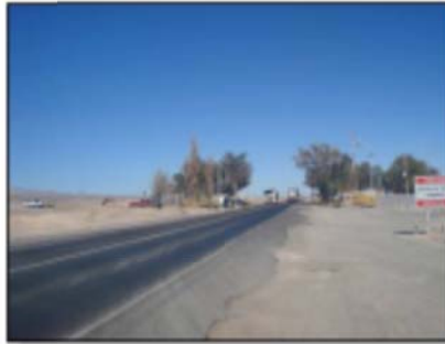
Km 107,8. Carabineros e instalaciones Enaer
